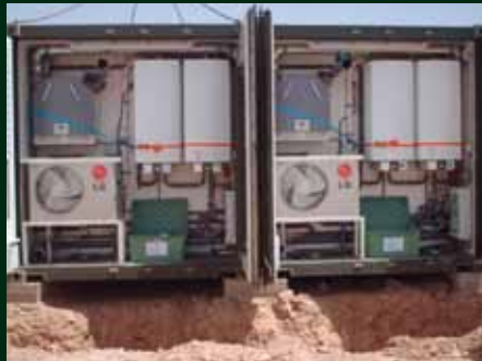
Technische ruimte sanitair containers
