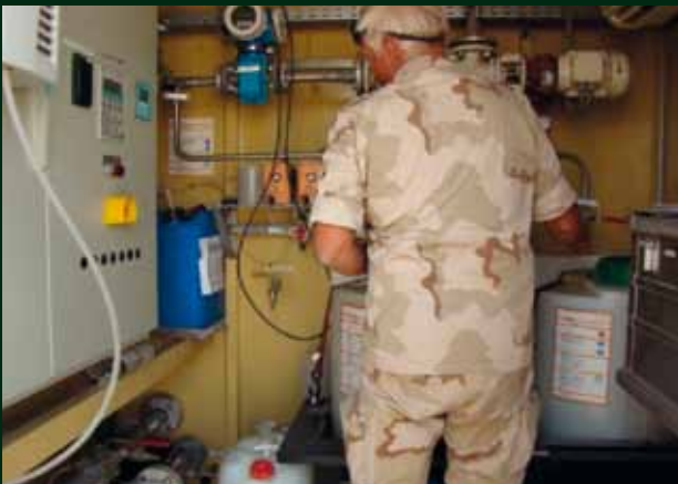
Besturing bioreactor en afvalwaterketen
