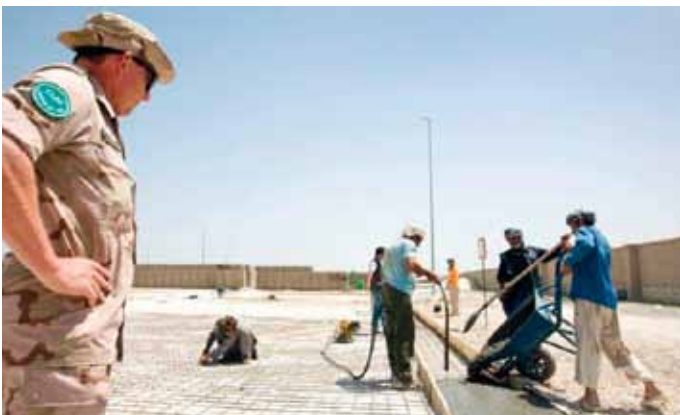
Betonnen plaat 30 x 50 m (B40)
