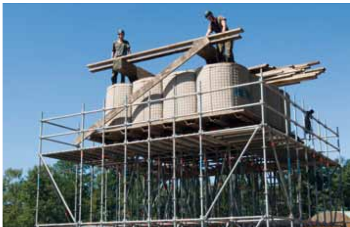
Ook het OTCGenie moet weer opnieuw in de steigers
