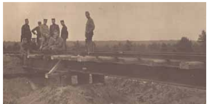
Het maken van een hulpspoorbrug in het spoorwerkkamp 'Biltsche Duinen' in 1910
