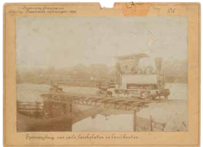
Spoorwegcompagnie. Verslag 'praktische oefeningen. Spoorbrug van rails, laschplaten en laschbouts 1899
