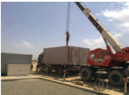
Verplaatsen dubbele container in zijn geheel
