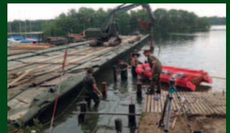
Steiger in aanbouw
