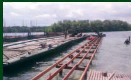
Het geraamte van de westelijke steiger
