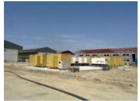
Powerplant in aanbouw
