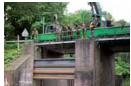
105 Gncie Wb in samenwerking met het waterschap. Hijskraan laat damwand zakken in de sleuf.
