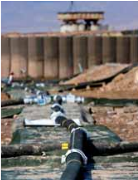
Het nieuwe BODS (Brandstof Opslag en Distributie Systeem). Het BODS vervangt de oude BRAVIN (Brandstof Voorzieningsinstallaties). Deze voldeed niet meer aan de eisen.
