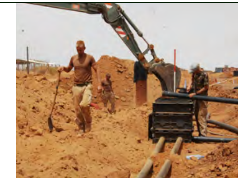
Uitputtende werkzaamheden; aanleg ondergrondse infra.
