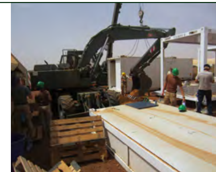
Bouw van een chalet door het constructiepeloton.
