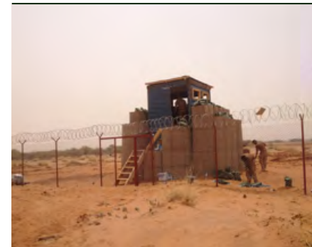
Bouw versterkte OP's door het pantsergeniepeloton.
