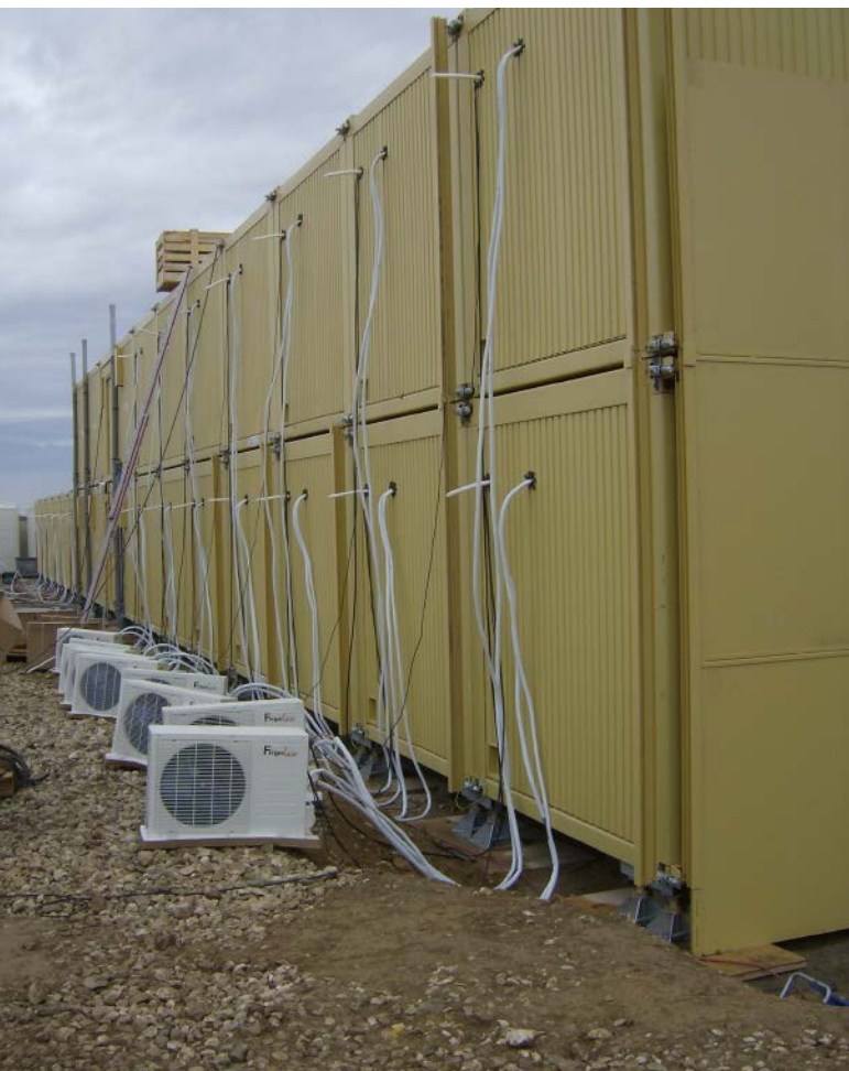
Koelen dmv individuele splitunits (koelen per ruimte). (Masar-e Sharif, ISAF Afghanistan 2011)
