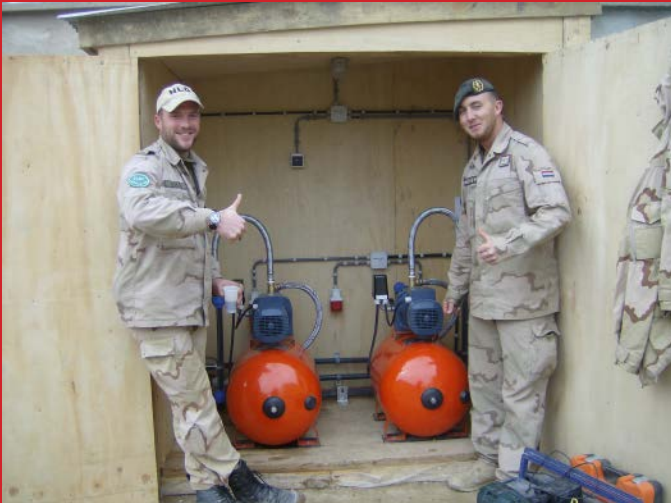
Geïmproviseerde DVI. Door een te lage lokale voordruk van het water is een tijdelijke installatie op locatie samengesteld zodat sanitair in gebruik genomen kon worden. (Masar-e Sharif, Afghanistan 2011)
