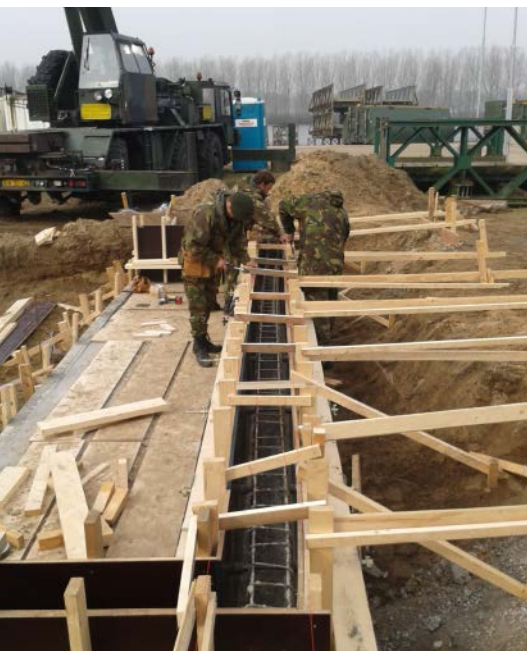
Bouw betonnen landhoofd Engelse Gat
