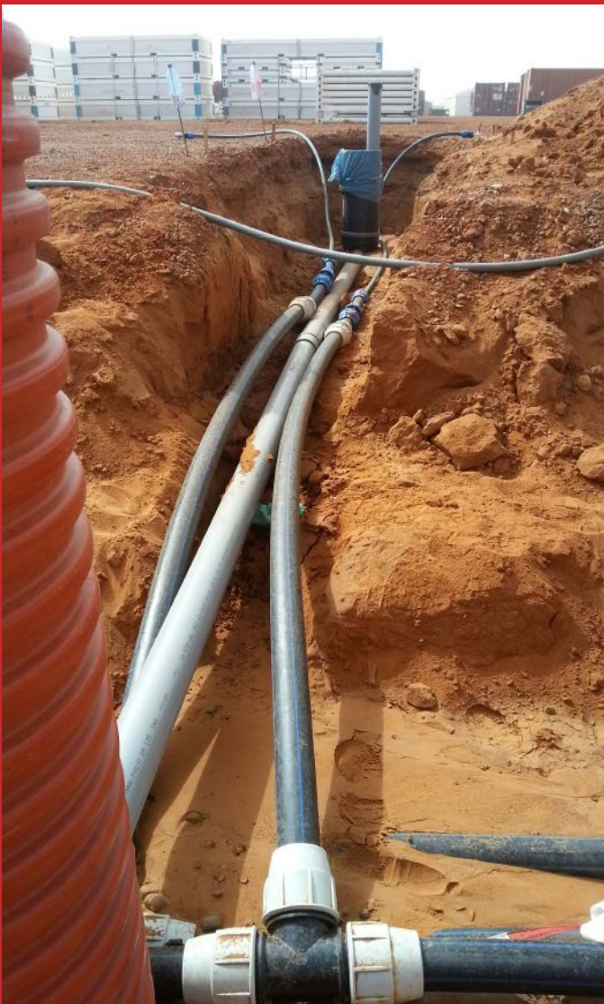
Aanleg ondergrondse infra tbv kamp Castor Mali. Complexe installatie door gebruik van diverse waterleidingen en rioleering. Samenwerking tussen GWW/IIT/IET. (MINUSMA GAO Mali 2014/2015)
