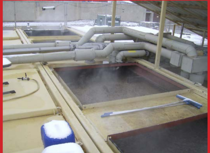
Membraan afvalwaterzuiveringsinstallaties. Het dmv geschaalde containers behandelen van afvalwater middels filters en bacteriën.
