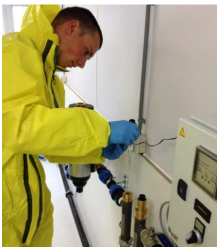
Opbouw van een UV-installatie om de gebruiker van de waterleiding te beschermen tegen onder andere legionellabesmetting en andere waterbesmettingen.
