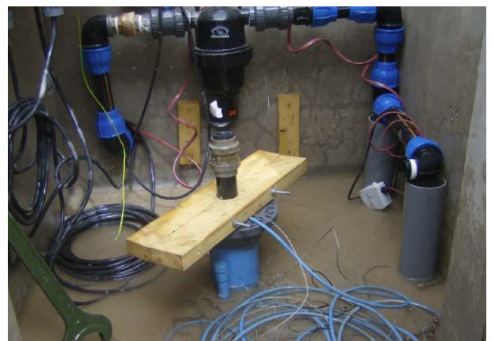
Samenhang van de diverse vakgebieden (IT, ET, WTB). Een bron geslagen door de waterboorgroep met een elektrische aansluiting tbv voeding bronpomp en de regelingen. Installatietechniek zorgt voor de aanvoer van water naar de gebruikers. (Tarin Kowt, Afghanistan ISAF 2010)
