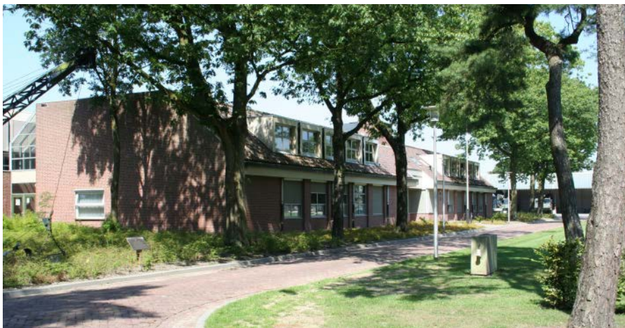
Gebouw S op de Van Brederodekazerne. Gebouwd in de jaren tachtig, als vervanging van de voormalige Schreijbustube uit de oorlogsjaren. Tientallen jaren was hier de Machinistenschool gevestigd en vanaf januari 2013 de response-eenheid van de J-CBRN School.
