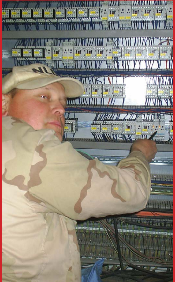
Complexe regeling afvalwaterbehandelingsinstallatie. Samenwerking tussen ET/IIT. Geeft goed de toepassing van Mechatronica in de toekomst weer.
