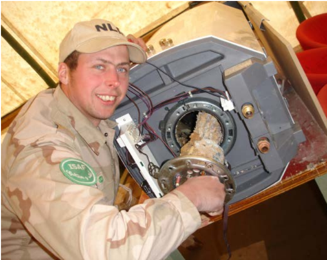
Onderhoud aan boilersystemen. Door hoge hardheid van het water extreme kalkafzetting wat grote onderhoudsinspanning vergt. (TK ISAF Afghanistan 2006-2010)
