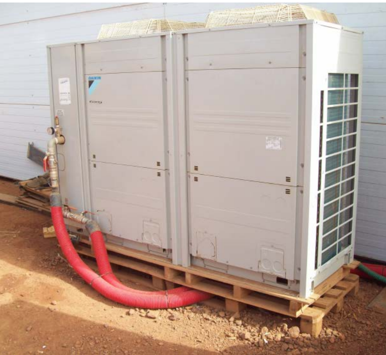
Dmv Chillers (grote koelinstallaties) wordt water gekoeld waarna het naar een luchtbehandelingskast geleid wordt. Daarna wordt dmv een warmtewisselaar koeling gegeven aan de langskomende lucht. (Minusma Gao, Mali 2014-2015)
