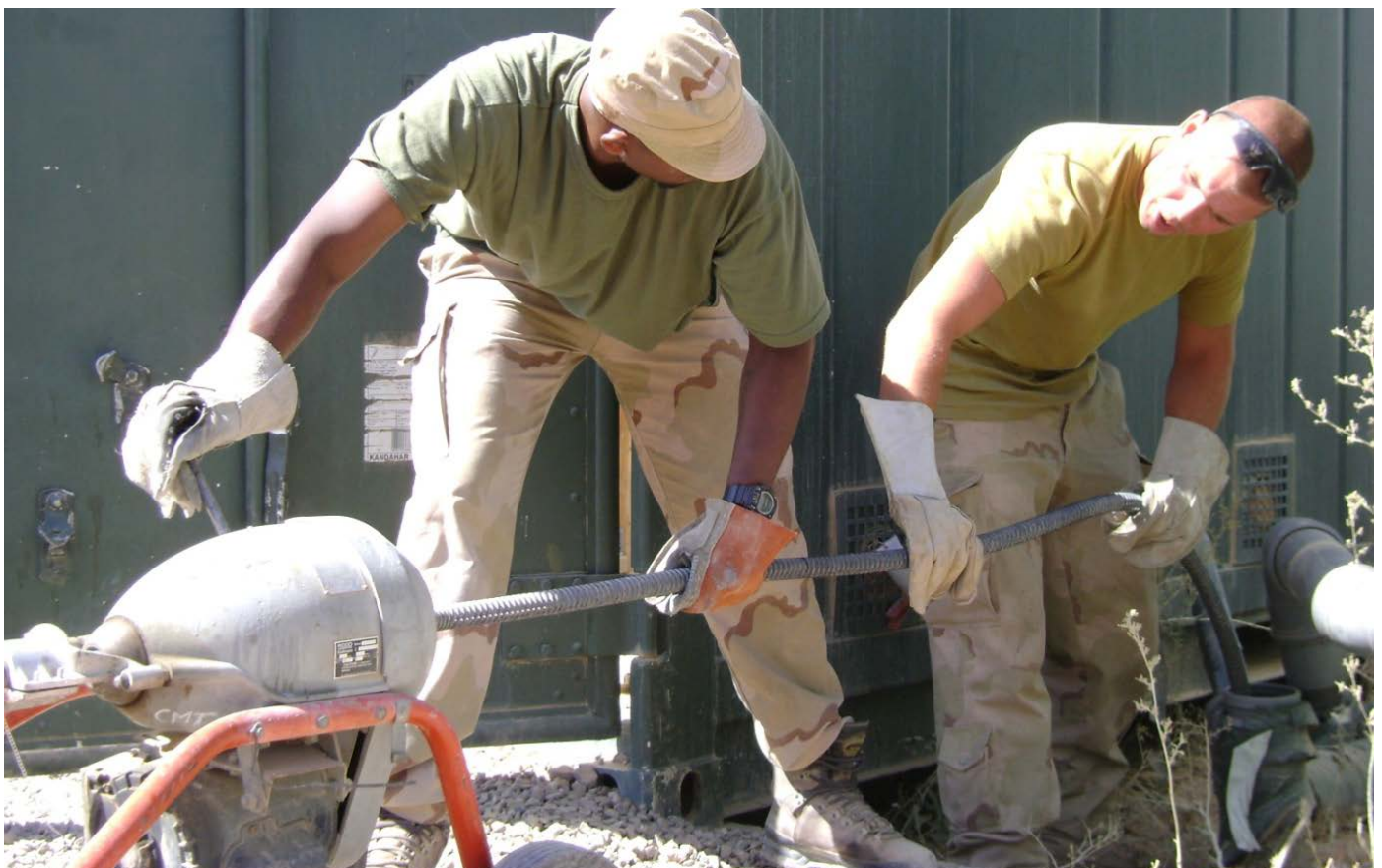
Storingen oplossen aan riolering. (TK ISAF Afghanistan 2006-2010)
