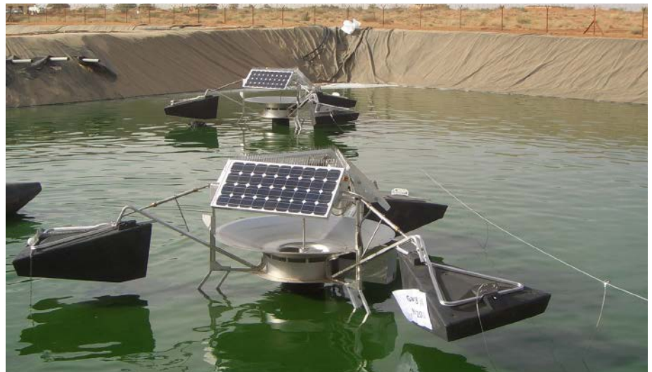
Eerste stap in zuivering van afvalwater dmv toepassen Solar Bee. (Minusma GAO, Mali 2015)
