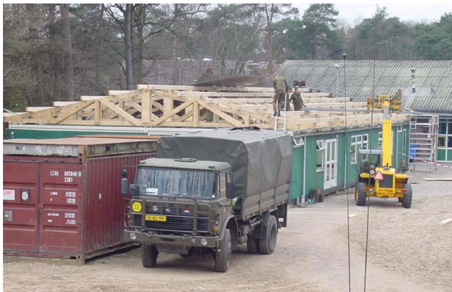
Het vervangen van het dak van de pionierslokalen op het 'pioterrein' op de Lunettenkazerne, eind jaren negentig.
