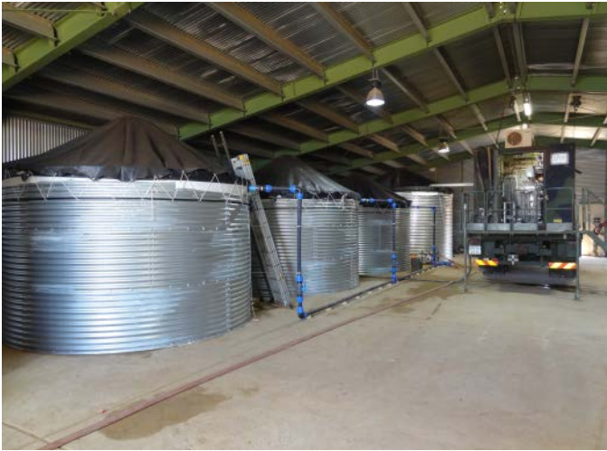
Opbouw watereland tbv opslag en behandeling van water in samenwerking met Mobile Drinkwater Installatiegroep van 240 Diensten Cie. Opslagtanks tbv badwas-water, bronwater en de geplaatste zuiveringsinstallatie op de vrachtwagen. (Kamp Castor, Gao, Mali 2015)
