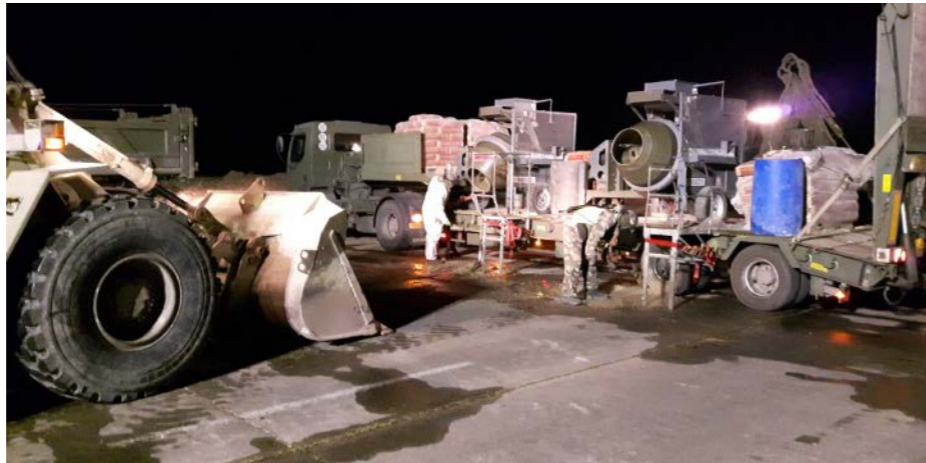
Franse manschappen aan het werk om de kraters te repareren
