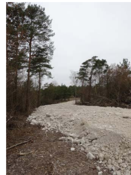
Aanleggen Combat Road
