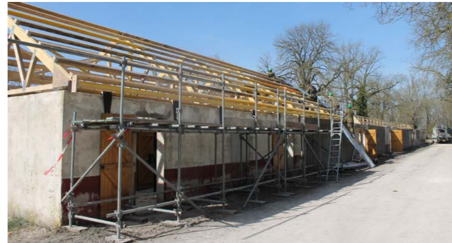
Eén van de dakconstructies
