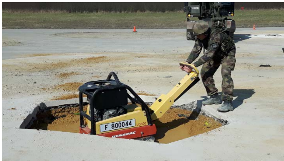
Een krater is uitgezaagd en uitgegraven waarna de bodem in lagen wordt verdicht. Een kleine krater zoals deze kan in vier uur gerepareerd worden.
