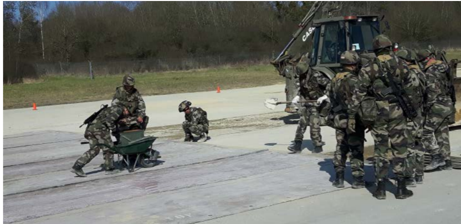
Een groep gaat fiberglas matten over een krater slijpen
