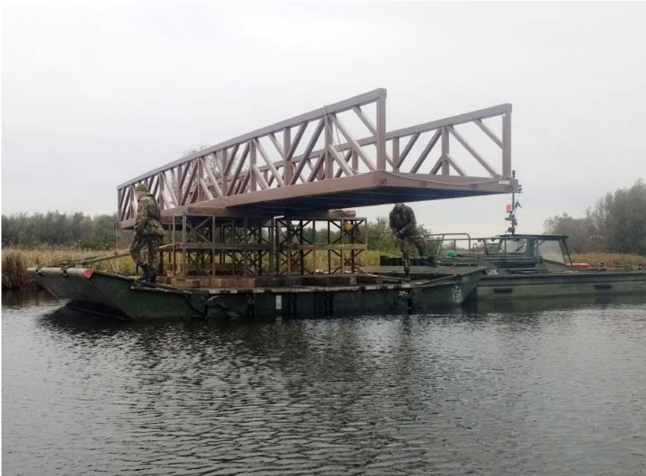
Het vervangen van een voetgangersbrug in een natuurgebied nabij Terneuzen
