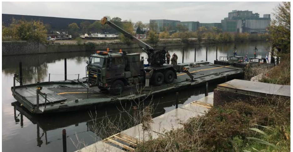
Het demonteren van een steiger in Hertogenbosch
