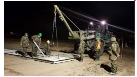
Aanleg helikopter landingsplaats
