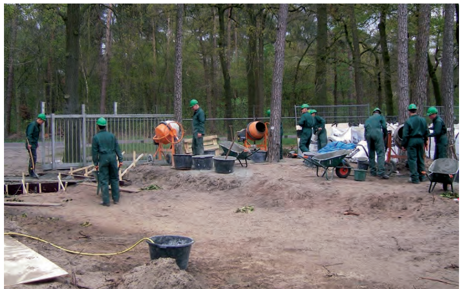
Leerlingen storten beton
